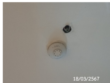
Smoke Detector และ Sprinkle Fire
